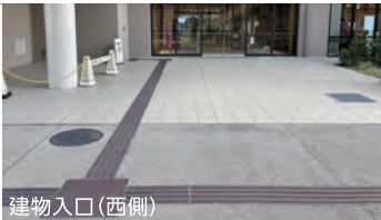
建物入口(西側)
