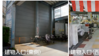
建物入口(東側)
