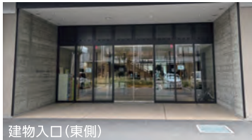
建物入口(東側)
