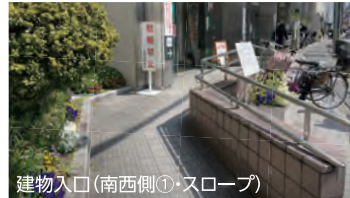
建物入口(南西側①・スロープ)
