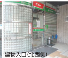
建物入口(北西側)
