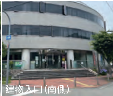
建物入口(南側)
