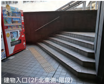
建物入口(2F北東側・階段)
