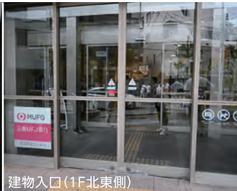
建物入口(1F北東側)
