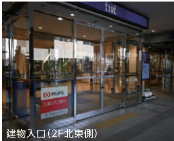
建物入口(2F北東側)
