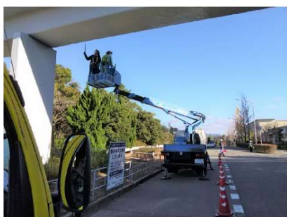
近接目視点検（打音による「うき」の確認）
