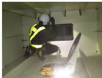
点検状況（検査口内部での点検）
