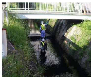
近接目視点検（桁下の点検）
