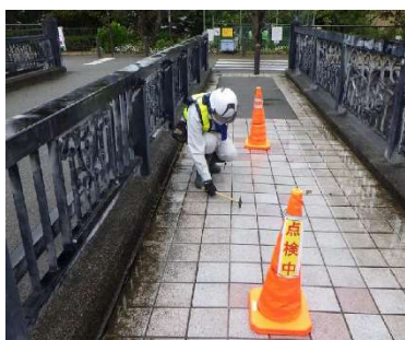
近接目視点検（路面の点検）
