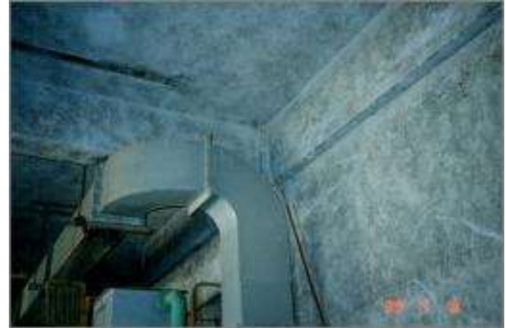
機械室の壁・天井の断熱
