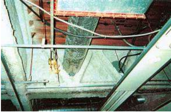
鉄骨造の梁・柱の耐火被覆
