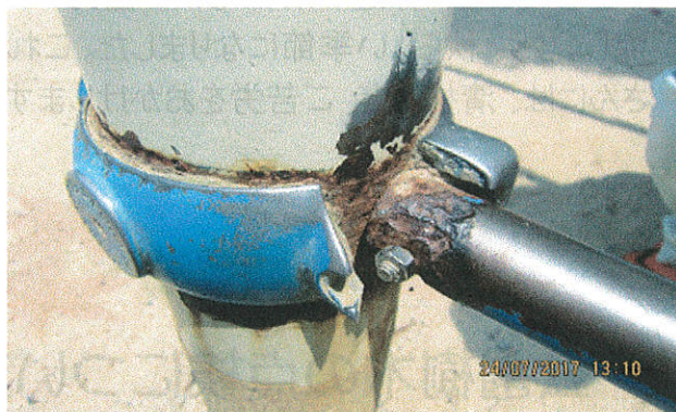
複合遊具の摩耗・劣化
