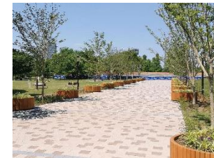
出入口、休憩施設付近 (ブロック舗装)
