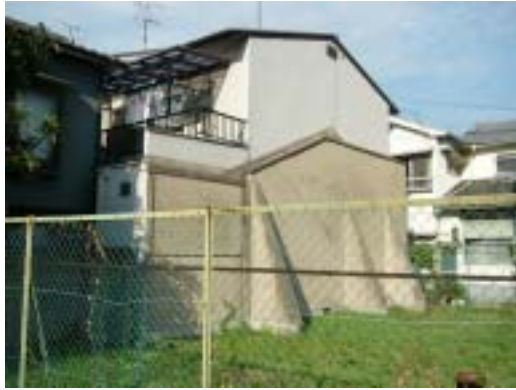
隣家の支え壁がある移転跡地
