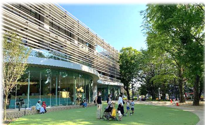
公園内の整備事例 板橋区立中央図書館
