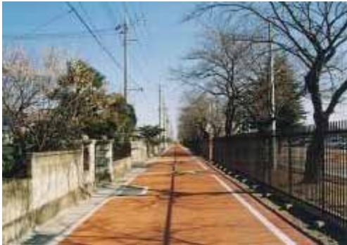
図 5-4 車道全体にカラー舗装を採用した事例
