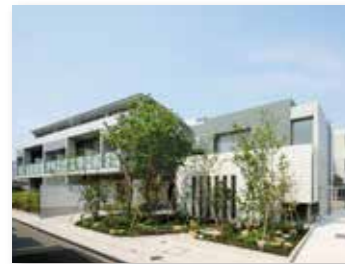
村田マンション アーティストコート 建築物
