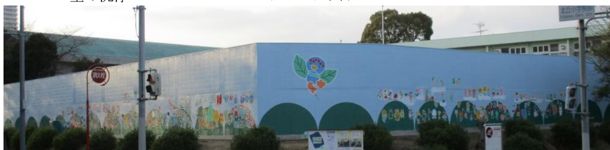
ペイント実施後の小学校プール外壁
