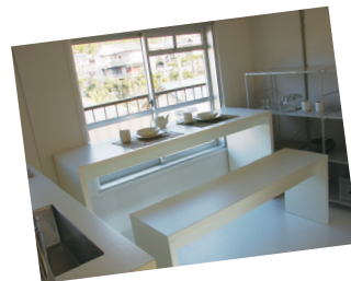
▲団地住宅のリノベーション(内装改修)
