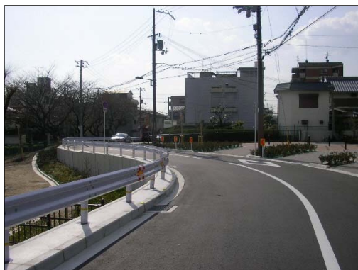
整備済み区間（庄内北回り線）
