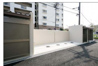
防災マンホールトイレ
