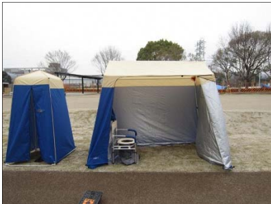
防災マンホールトイレ
