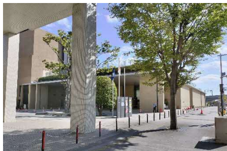
広場、歩道と調和した公共施設
