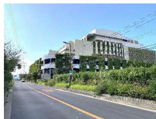
壁面緑化と敷際緑化でうるおい 豊かな焼却施設(原田西町)
