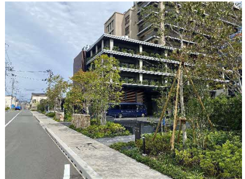
地区の再整備にあわせて都市景観形成推進地区を指定した北緑丘1丁目地区
