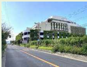
壁面緑化と敷地緑化でうおい 豊かな焼却施設（原田西町）
