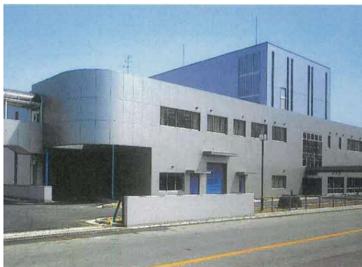
【工場倉庫のまちなみ】 クリーンランド 当初
