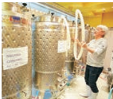
特注タンクの上下を固定して大地震でも倒れないように配慮されています。
