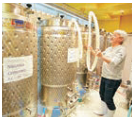
特注タンクの上下を固定して大地震でも倒れないように配慮されています。
