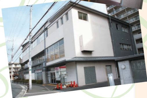
エレベーターが更新された 服部介護予防センター。
