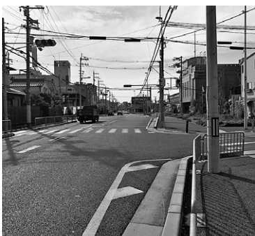
整備中の都市計画道路三国塚口線（豊中南部防署東側交差点付近）
