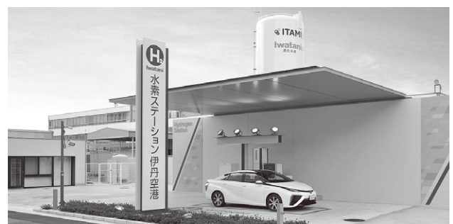
大阪国際空港内にある水素ステーション
