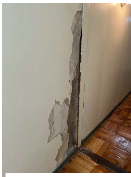
壁が剥離している
