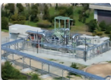
⑭ 消化ガス発電事業
