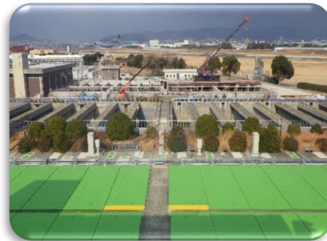
⑦ 雨天時汚水処理施設
