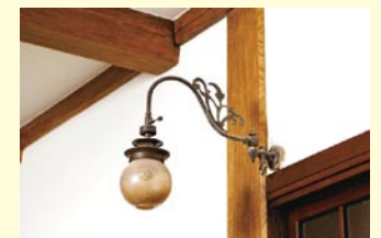
食堂に設けられた建築当初からと見られるガス灯
