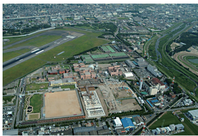
原田処理場の全景
