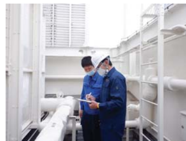
受水槽の管理状況調査の様子
