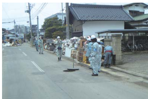
東日本大震災の被災地での下水道管調査のようす (宮城県多賀城市)
