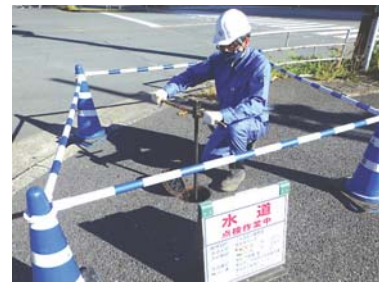
水道施設の点検のようす
