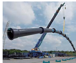
耐震管※のデモンストレーション
