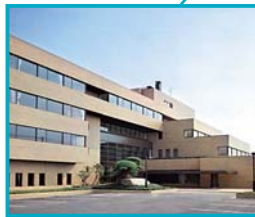
上下水道局庁舎
