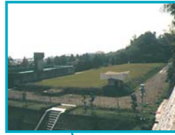
柿ノ木配水場
