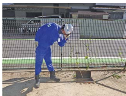
漏水防止活動のようす
