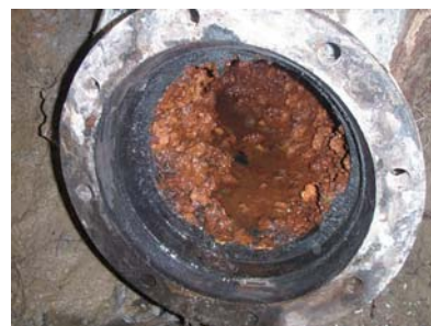
古くなった水道管の内部
