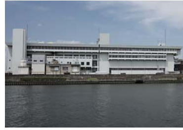
庄内下水処理場
