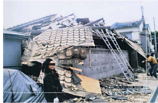
平成7年（1995年）1月17日に発生した阪神淡路大震災で被害を受けた家屋（庄内栄町）
