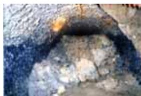
硫化水素 による下水道管の腐食
