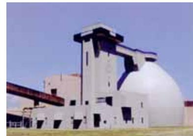
消化ガス を発生させる卵形消化タンク (原田処理場)
