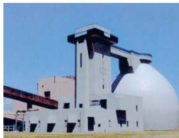
消化ガス※を発生させる卵形消化タンク（原田処理場）
