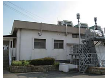
老朽化が進んでいるポンプ場 (小曾根第1ポンプ場)
