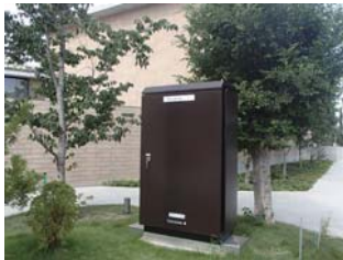
24時間常時監視している水質モニター (曽根東町)
