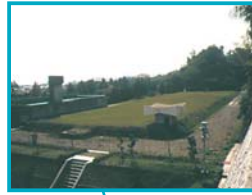
柿ノ木配水場
