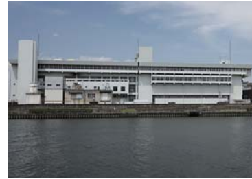
庄内下水処理場
