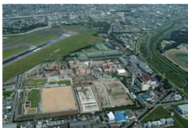
原田処理場の全景
