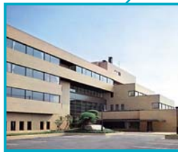
上下水道局庁舎
