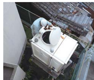
受水槽の管理状況調査のようす
