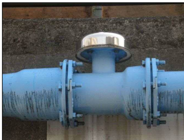
(写-2) 不凍式空気弁
