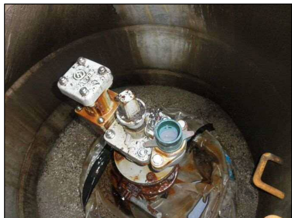
(写-4) 空気弁付き排水栓
