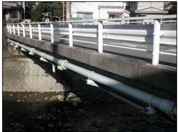
(写-10) 橋梁添架橋
