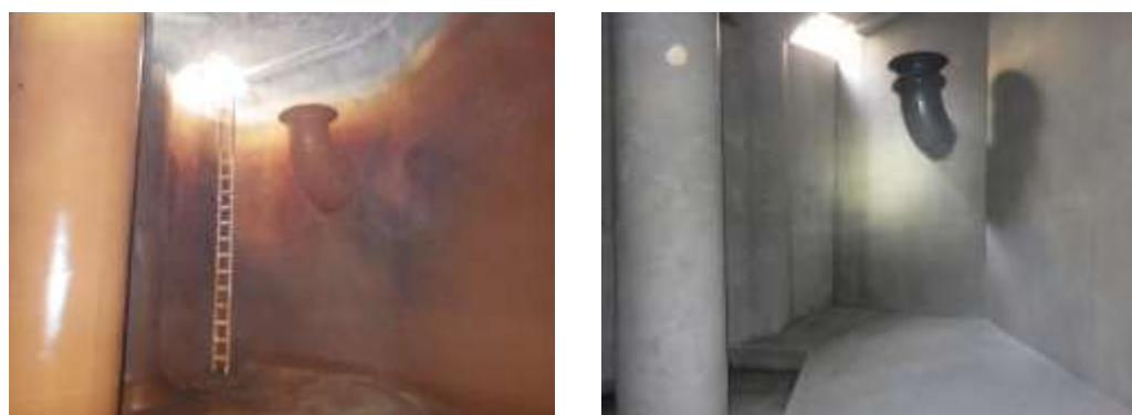
図 2.2 寺内配水池の耐震補強（左：耐震補強前、右：耐震補強後）
