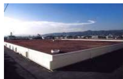
写真：野畑配水池
