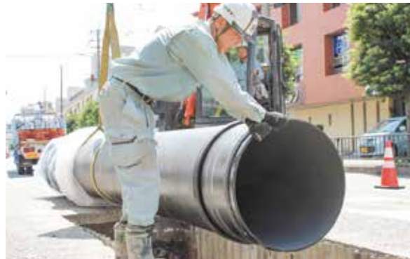
新しい管は100年以上の使用期間を見込んでいます
