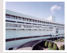
庄内下水処理場
