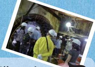
工事現場の見学
