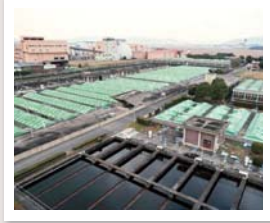
猪名川流域下水道原田処理場
