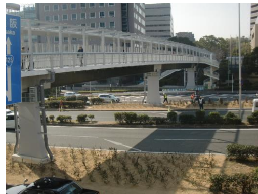
千里橋補修・耐震補強・ 防風パネル・屋根等完成写真
