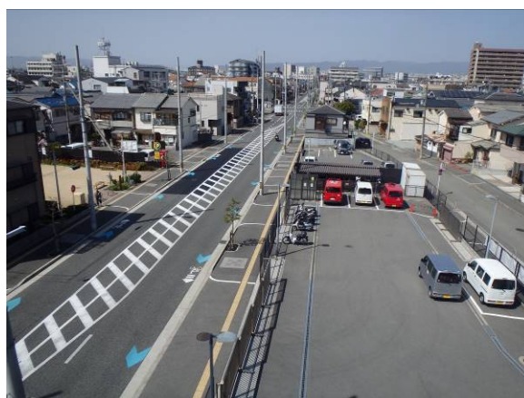
完成区間／三国塚口線以北
