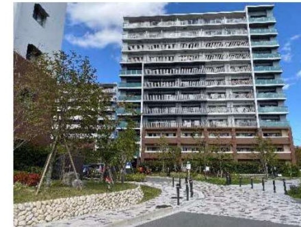
府営住宅などの団地系住宅の建替え
