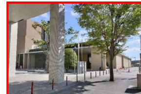
広場、歩道と調和した公共施設
