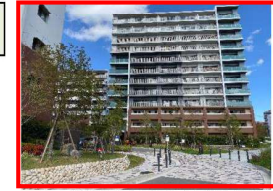
建て替えにより新たな景観を創出 (UR千里東グリーンビル東中)
