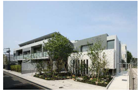
緑化スペースを十分配置したマンション 都市デザイン賞を受賞（豊南町西）
