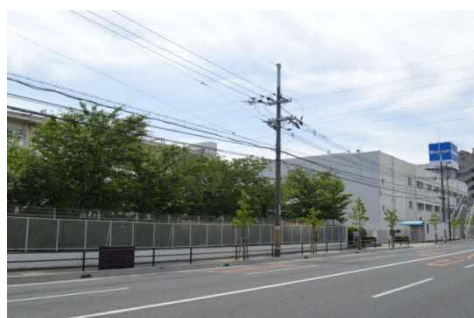
工場のまちなみ（稲津町）
