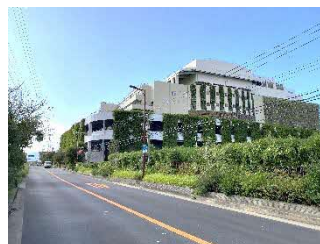
壁面緑化と敷地緑化でうるおい 豊かな焼却施設(原田西町)
