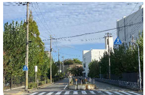
うるおいある工場・倉庫のまちなみ（二葉町）
