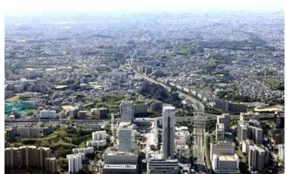
建築物や緑等が調和したまちなみ（千里中央地区から南方向を望む）
