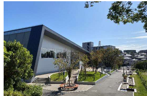
二ノ切温水プールとエントランス空間
