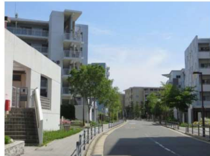
建て替えにあたって建築物のデザインの調査がなされた団地（URラ・レル東豊中）
