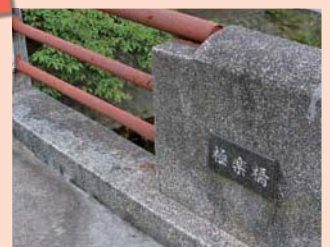
広田町の服部霊園に向かう道にかかる極楽橋
