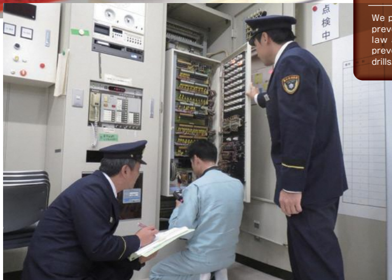
立入検査 Inspections
