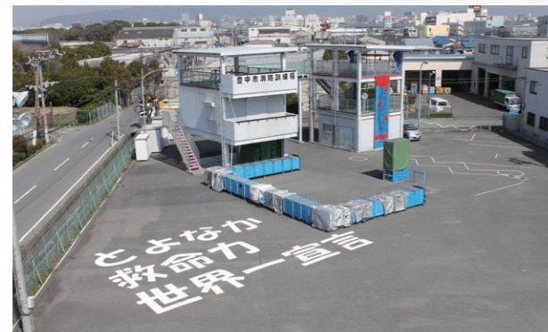
消防訓練場 Fire Training Facilities
