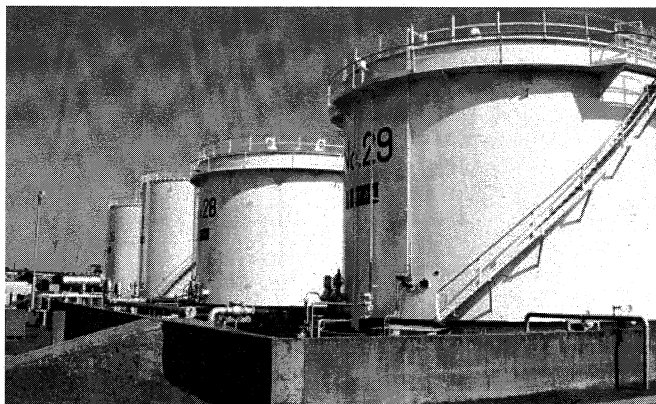
屋外タンクの状況
