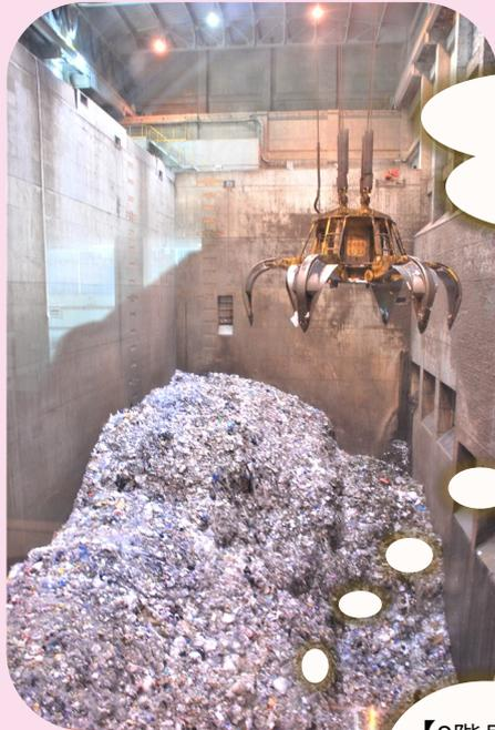
【4階展示ホール】豊中・伊丹両市で収集された可燃ごみを集めるごみピットが見えます。ごみの搬入量は年間15万トンにもおよび、自動制御装置で24時間稼働するごみクレーンがごみを移動、攪拌、混合し、焼却炉投入に向けてごみの塊をほぐして燃えやすくしています。
