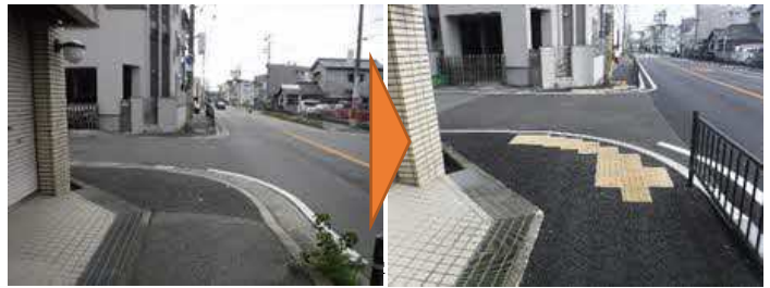
歩道改良実施計画に基づく整備
