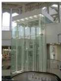
エレベーター設置 (せんちゅうパル)
