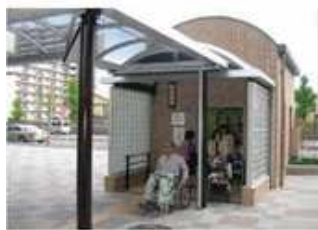
エレベーター設置
