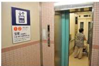
エレベーター設置 (庄内駅)
