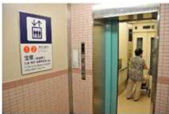
エレベーター設置 (庄内駅)
