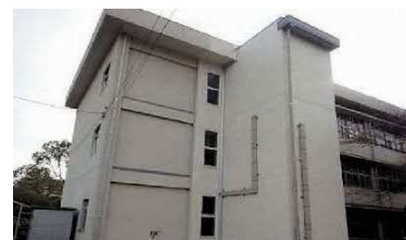
小中学校のエレベーター設置
