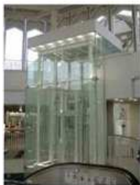
エレベーター設置 (せんちゅうパル)
