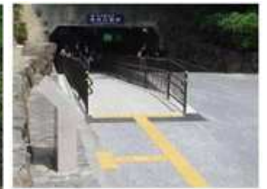
地上から緑道へのス ロープ・点字ブロッ ク設置
