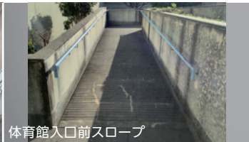
体育館入口前スロープ
