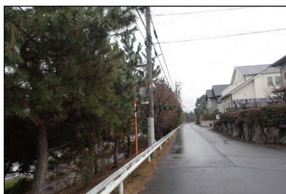
交通安全施設（カーブミラー）への支障
