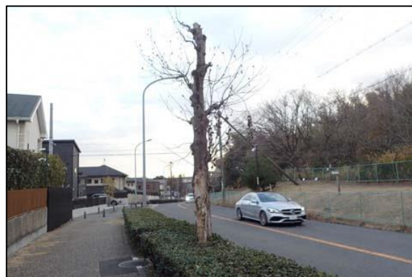
腐朽の進行による倒木の危険性の増大
