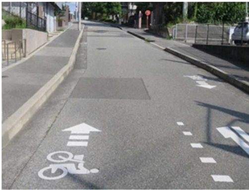
生活道路の例(吹田市)
