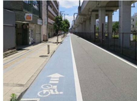
試験施工（阪急東側線）
