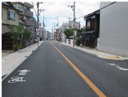
試験施工（東豊中線）
