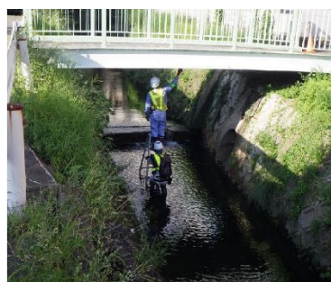
近接目視点検（桁下の点検）
