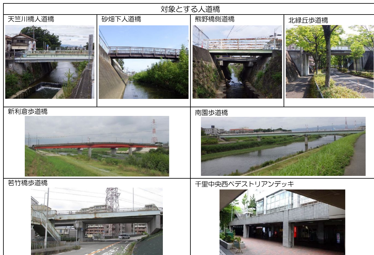
図 3-1 長寿命化修繕計画の対象とする人道橋の状況
